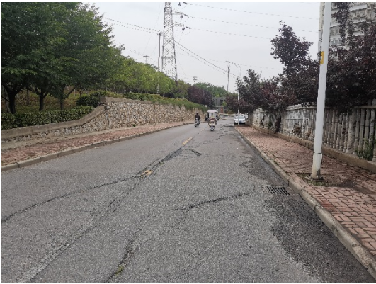
现状西侧景观挡墙
