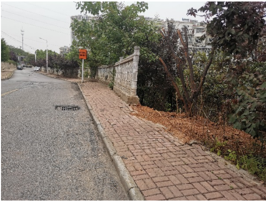
现状东侧路肩挡墙
