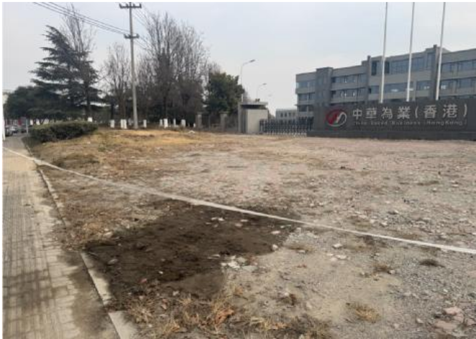
厂前公共区域现状原位铺装层，破损严重
