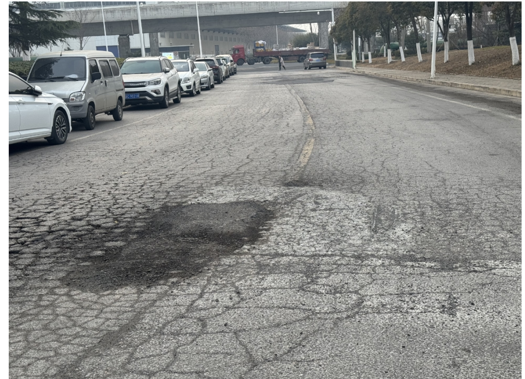
（车行道范围内道路破损严重）
