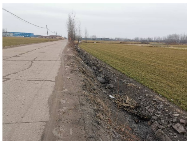
现状边沟 (A线)
