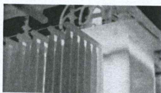
电力设备检修
